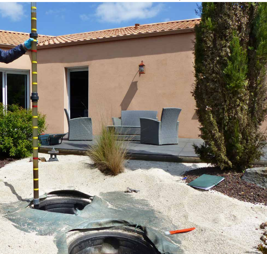
en visite de contrôle d'une micro-station dans le cadre d'une vente de maison.
